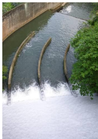
雙翠水壩洩洪道
